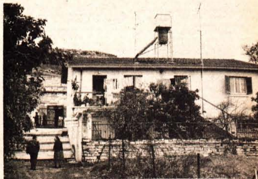
Ciper ima menda najboljše podnebje v Sredozemlju. Ogromno sončnih dni izkoriščajo domačini za ogrevanje sanitarne vode in take kolektorje, kot ga vidite na strehi hiše na fotografiji, smo tam videli povsod, tudi na barakah.
