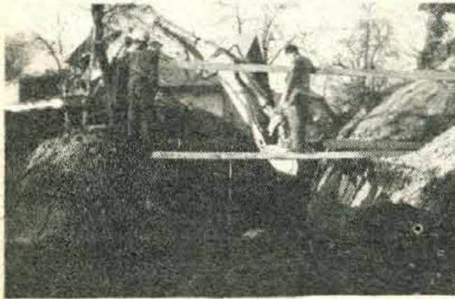
GORJE — Podjetje Hidrotehnik iz Ljubljane dela kanalizacijo v Spodnjih Gorjah. Ta kanalizacija poteka od nekdanje Gorjane skozi stari predel v Spodnjih Gorjah in novega naselja do Černeta. Vsa trasa je dolga 900 metrov, dela pa financira samoupravna komunalna interesna skupnost Radovljica — Foto: J. Ambrožič
