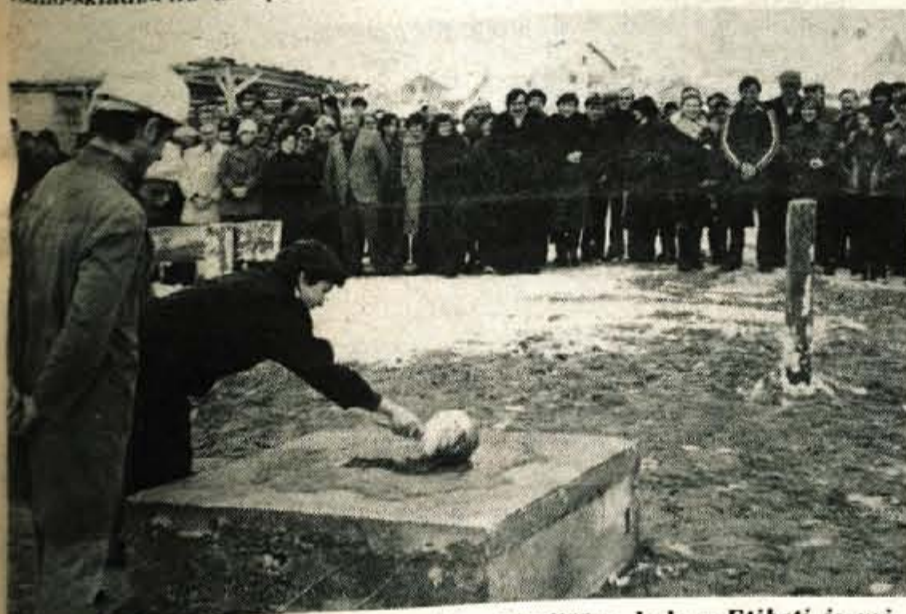
Temeljni kamen za novo proizvodno-skladiščno halo v Etiketi je vzdala Olga Strlič, ki je članica kolektiva že od ustanovitve in sicer od l. 1959. leta. — Foto: J. Zaplotnik
