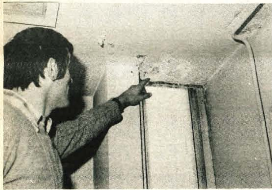
Strop na stopnišču na Gubčevi 7
