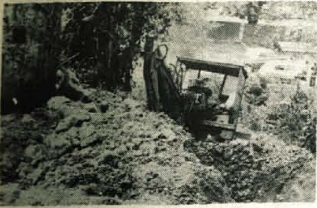
IZGRADNJA VODOVODA NA JESENICAH — Delavci jeseniške delovne organizacije vodovod nadaljujejo z izgradnjo vodovoda od Peričnika do Korolje Bele. Ta čas napeljujejo debele plastične cevi od železniške postaje proti tržnici in bližnjemu naselju. Posnetek pa kaže kopanje vodovodnega jaska pri Aljaževem stolpu ob poti na jeseniško tržnico. — B. B.
