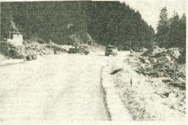
OBVOZNIKA JE ŽE ASFALTIRANA - Izgradnja obvoznice in nove ceste od mejnega prehoda pri Račeh proti Podkorenu dobro poteka. Delavci cestnega podjetja iz Kranja so že položili asfalt od meje do izvira Save. Od tod naprej pa staro cesto proti Podkorenu izravnavajo in širijo. Pri tem morajo napraviti več velikih odkopov zemlje. B. B.
