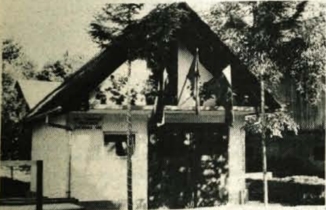
DVORSKA VAS — Vaščani so prispevali material in delo za novo orodjarno v vasi. — Foto: F. Perdan
