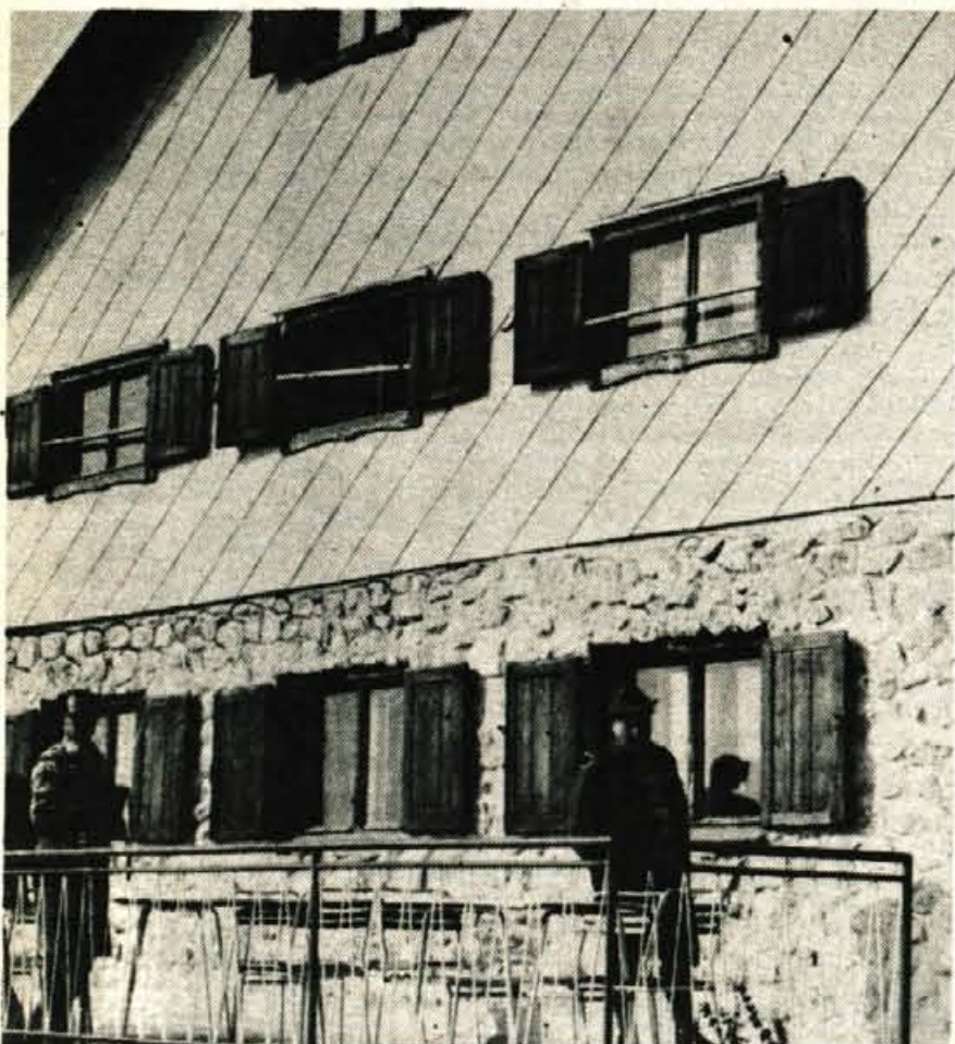
KALIŠČE ČAKA NA POPRAVILO – Kališče in njegov Dom Kokrškega odreda je med najbolj priljubljenimi in lahko dostopnimi planinskimi postojankami. Le dve uri hoje terja vzpon, zato ni čudno, če letno obišče Kališče nad 15.000 ljudi. Vendar je Dom, zgrajen leta 1959, dotrajan. Planinsko društvo Kranj je k postojanki že pripeljalo potreben gradbeni material. Komisija je ocenila, da je dom prizadel tudi potes. Rekonstrukcija se bo kmalu začela, vendar bo dom vseeno obratoval. (jk) – Foto: F. Ekar
