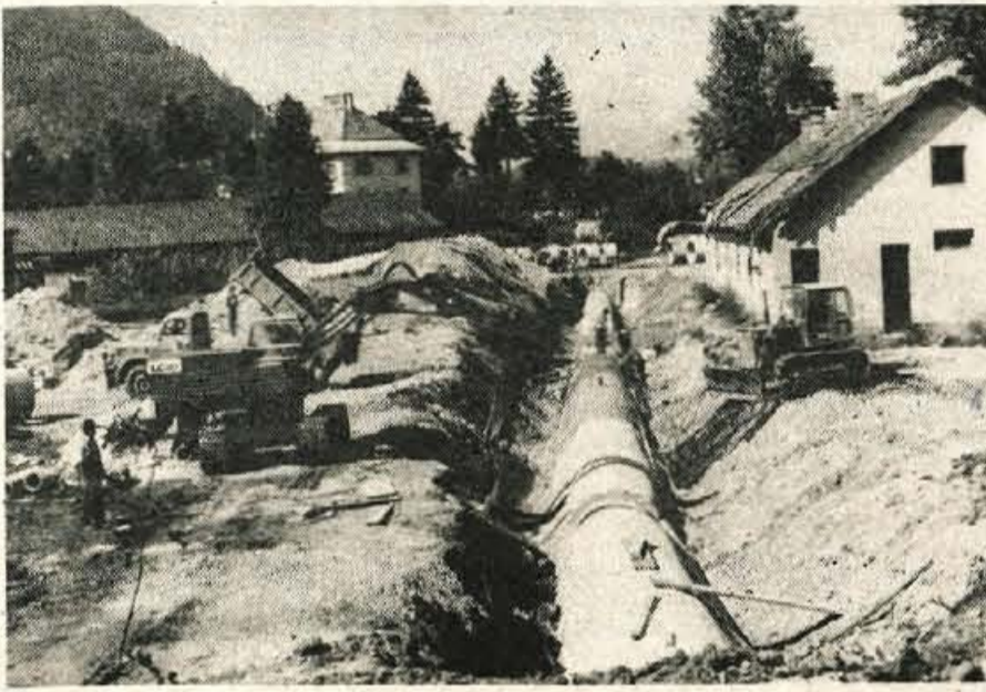
Gradnja glavnega zbiralnika GZ-4 pri Iskri
