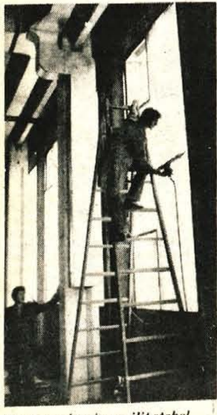
Montaža oken in copilit stekel
