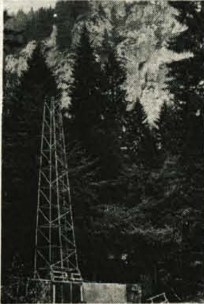
Na 1220 metrov nadmorske višine stojijo vrtine za predvideni cestni predor Karavanke...
