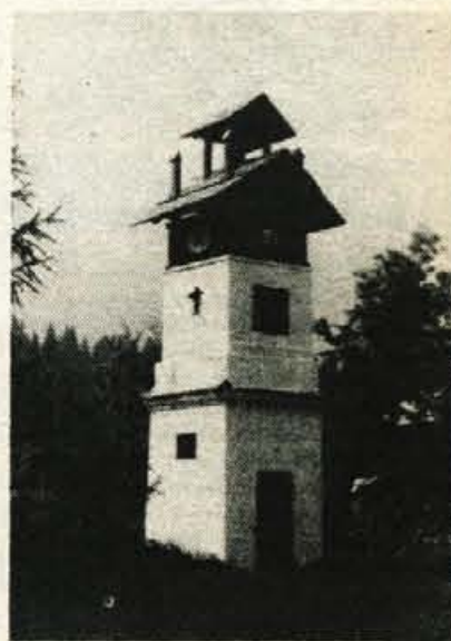
Cojzova stolpna ura na temeljih starega plavža - sta Pozabljenem pri Bohinjski Bistrici
