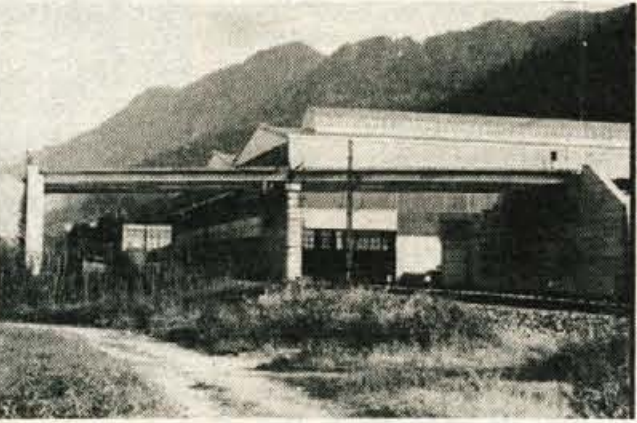
JESENICE - Delavci GIP Gradis, temeljne organizacije združenega dela Jesenice so zgradili nov, približno 30 metrov dolg most za cesto h klučnici. Zdaj urejajo še cesto na obeh straneh mostu. - B. B.
