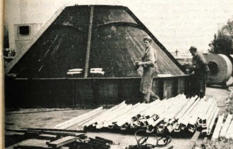
Bohinjska Bistrica — Delovna organizacija Filbo se razvija v uspešno podjetje, vendar so preostali prostori ostra razvoja. Zato so se lotili gradnje novih prostorov. Gradbena dela so zaupali Trinu iz Trebnjega in gradbenemu podjetju Bohinj. Nova proizvodna hala raste v bližini bohinjske železniške postaje. — B. B.
