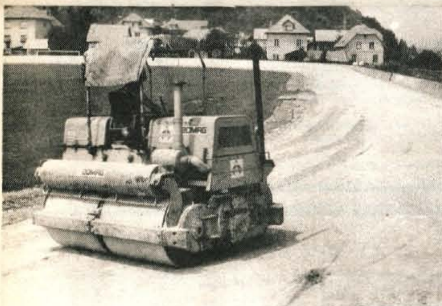
Kolesarska steza – Na nekdanji speedwayski progi v Stražišču že bomo stroji GIP Gradis in pripravljajo teren za asfaltiranje. Kolesarska steza, ki bo gotova do jeseni, bo dobrodošla predvsem kolesarjem domačega kluba Sava, uporabljal pa jo bodo lahko tudi rekreativci in šolarji. (H. J.) – Foto: F. Predan
