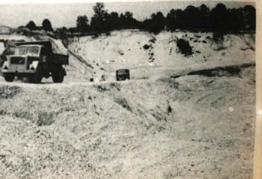
Ribno – Obrtno podjetje Grad odvažajo iz gramoznice v Ribnem velike količine materiala, zato je razumljivo, da težki tovornjaki uničujejo ceste. – Foto: F. Perdan
