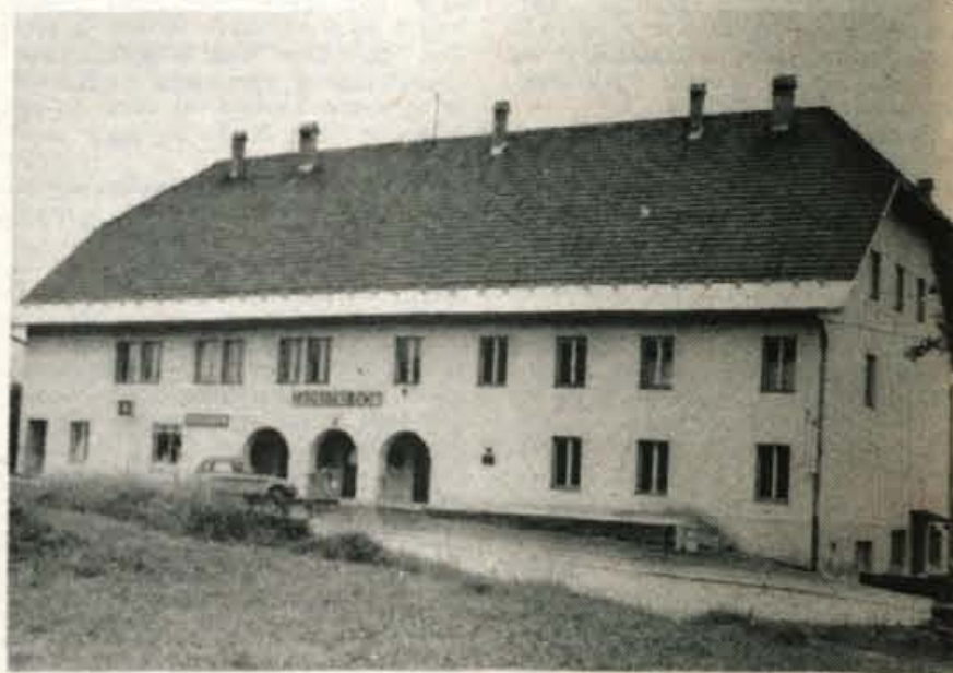
Ribno – Za zadružni dom v Ribnem si krajevna skupnost prizadeva, da bi pridobili lastništvo in ga ustrezno obnovili. – Foto: F. Perdan
