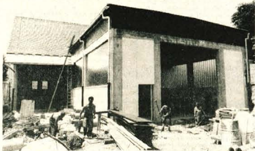
Radovljica — Na Gorenjski cesti v Radovljici gradi Merkur Kranj — Železnina Radovljica novo železninarsko skladišče. Z deli so začeli februarja letos, skladišče pa naj bi bilo zgrajeno čez dva meseca. Površina pokritih prostorov bo znašala 425 kvadratnih metrov, pred skladiščem pa bo še okoli 300 kvadratnih metrov dvorišča. Novo skladišče bo stalo približno 380 milijonov dinarjev, izvajalec del je GP Gradbincev Kranj. (F) Foto: F. Perdan
