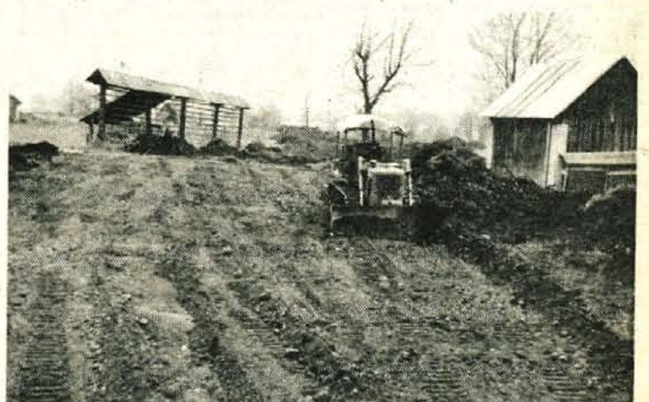
Rateče - Cestno podjetje iz Kranja je v Ratečah začelo graditi novo cesto, ki bo dolga okoli pet kilometrov. Nova cesta bo speljana od podkorenške obvoznice do začetka Rateč po stari cesti, pred Ratečami pa se bo odcepila in bo speljana južno od vasi, kjer se bo nato priključila na sedanjo cesto na mejnem prehodu z Italijo. Nova obvoznica je v Ratečah zelo potrebna, saj je cesta skozi vas slaba in predstavlja ozko grlo. Obvoznico bodo gradili v dveh etapah. Letos bodo zgradili cesto do križišča, ki povezuje cesto v Planico do državne meje, naslednje leto pa bodo začeli z deli na cestniški od Podkorena do Rateč. Začasno bo promet usmerjen po obvoznici nekdanje železniške proge. - Foto: A. Kerštan
