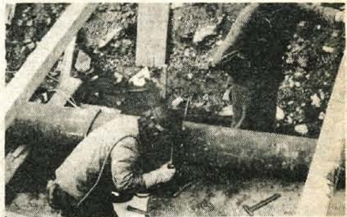
Jesenice — Graditev toplovoda do šolskega centra na Plavžu se spet nadaljuje. Občani si bodo oddahnil, ko bodo delavci Kovinarja lahko zasuli globoke in široke izkope, ki so doslej ovirali dostop k stanovanjskim poslopjem in dovoz avtomobilov na parkirne prostore. — B. B.
