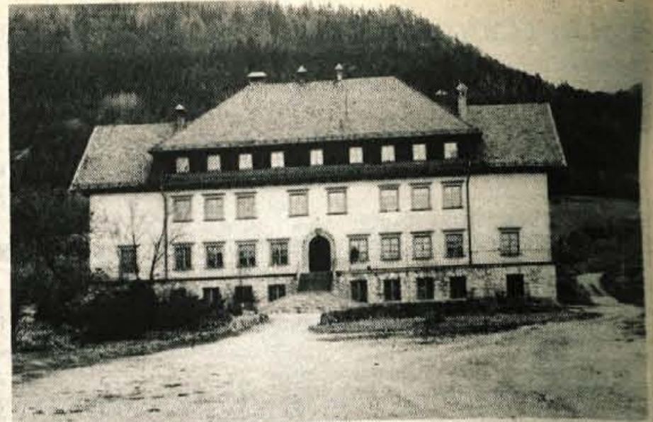
Obnovitvena dela v nekdanji kmetijski šoli v Poljčah bodo stekla že letos. - Foto: J. Zaplotnik
