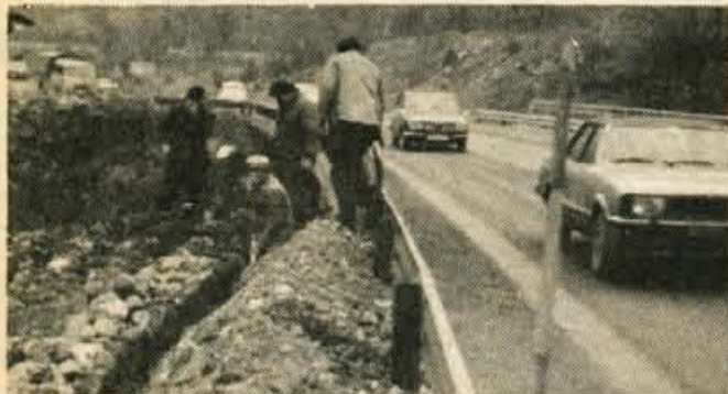
Moste - Delavci PTT Kranj predstavljajo telefonski kabel, ki je speljan od Most proti Jesenicam. To je potrebno zato, da bodo delavci, ki grade na tem odseku plinovod, lahko nadaljevali z delom. - Foto: B. B.
