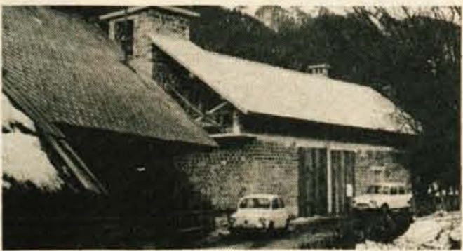
Planina pod Golico - Prostovoljno gasilsko društvo Planina pod Golico gradi nov dom gasilcev. Za zdaj so ga že pokrili s streho, z deli pa bodo nadaljevali leta 1980. Sredstva za obnovo so prispevala občinska skupnost za varstvo pred požarom, delovne organizacije in vaščani. - B. B.
