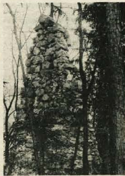
Ostarek obrambnega stolpa gradu Rožek.
