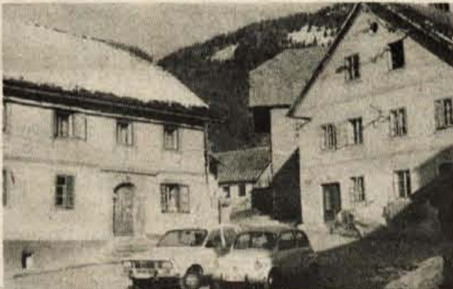
Rateče — Nekdaj so vasi gradili tako, da so stale hiše zelo blizu ena drugi, da so tako ohranili rodovitno zemljo. Skozi naseleja so speljali ozke ceste in pota. Današnja motorizacija pa takšnih ožin skorajda ne more več prenašati, zato gradijo obvoznice. Zgradili so jih že mimo Kranjske gore, mimo Podkorena, prihodnje leto pa bodo obvoznico začeli graditi tudi mimo Rateč. Na sliki: ozka rateška cesta. — Foto: B. B.
