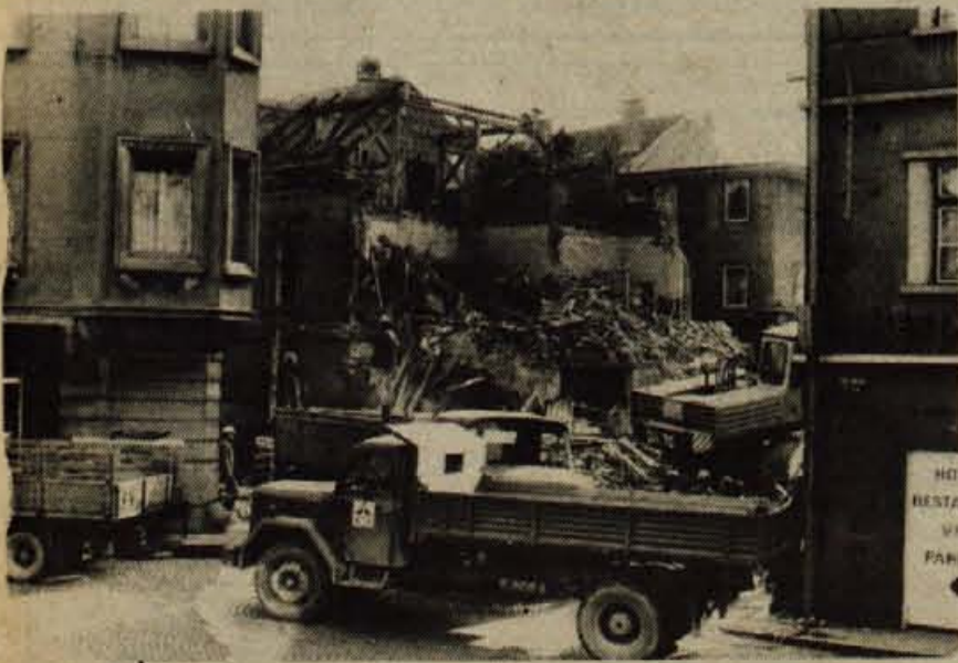
Rušenje za Merkurjem - V Kranju so pred dnevi začeli rušiti poslopje za Merkurjevo trgovino ob hotelu Jelen. V njem so bili poslovni prostori in tudi nekaj stanovanj. Ker je bila stavba dotrajana in neuporabna in ker so dobili stanovalci primernejša stanovanja, se je odločil Merkur za rušitev. Ker novogradnja na tem mestu ni predvidena, bo za Jelenom in sedanjo trgovino urejeno parkirišče, razen tega pa bo manj gneče. (jk) - Foto: F. Perdan
