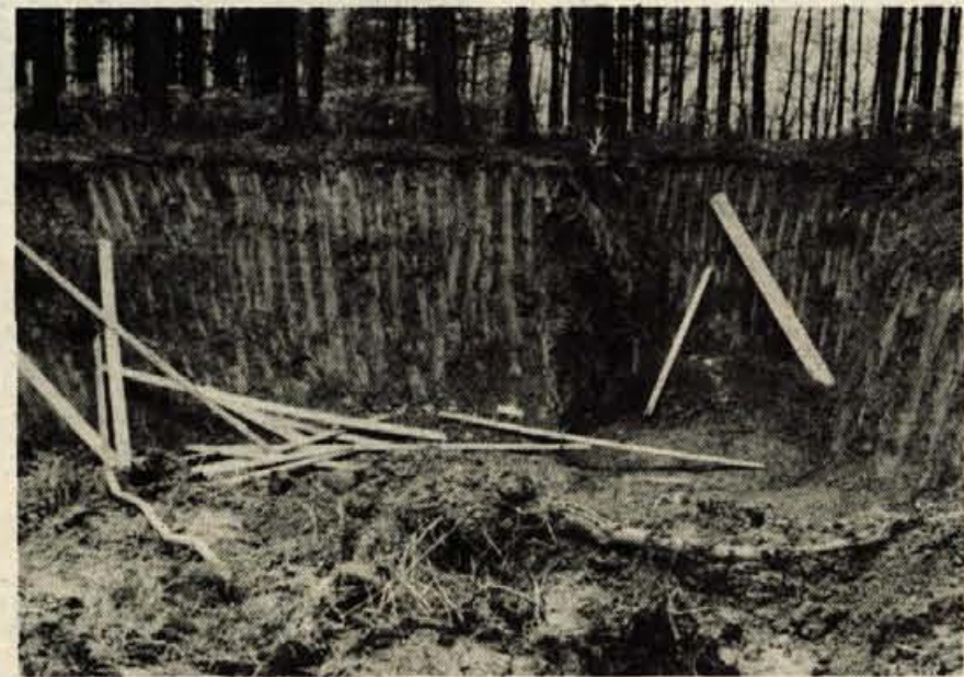
Zemeljska dela za nov vodovodni rezervoar nad Pivko bodo kmalu končana - Foto: F. Perdan
