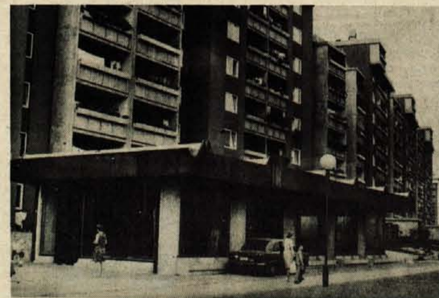
Kranj - Ljubljanska banka, podružnica Kranj gradi v novem stanovanjskem naselju na Planini v Kranju novo ekspoziuro. Celotna gradbena in druga dela je prevzelo Splošno gradbeno podjetje Gradbinec, končana pa naj bi bila v oktobru. Po otvoritvi bo nova ekspoziura kranjske podružnice Ljubljanske banke odprta vsak ponedeljek in torek popoldne, ob sredah ves dan in ob četrkih in petkih dopoldne. Prebivalci Planine bodo v tej ekspoziuri lahko opravili vse bančne posle. - A. Ž. - Foto: F. Perdan
