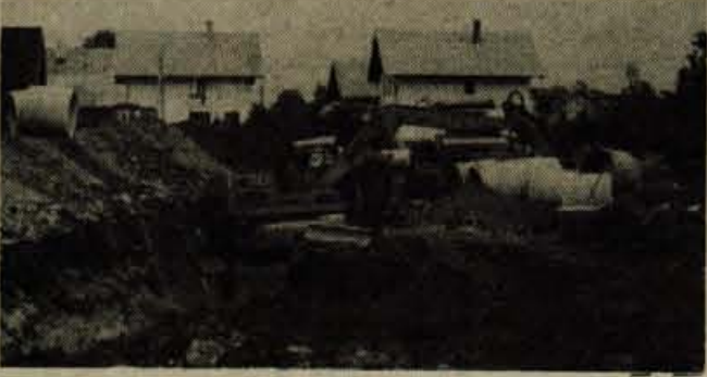
Lesce - Kanalizacija - Delavci Komunatnega podjetja Kovinar Jesenice grade v Lescah kanalizacijo in dovozno cesto, ki bo speljana od novega skladišča Žita. Kanalizacijo bo uporabljalo leščansko Žito, priključila pa se bo kanalizaciji tovarne verig Lesce. Graditev ceste in kanalizacije financira Žito Ljubljana. — Foto: B. B.
