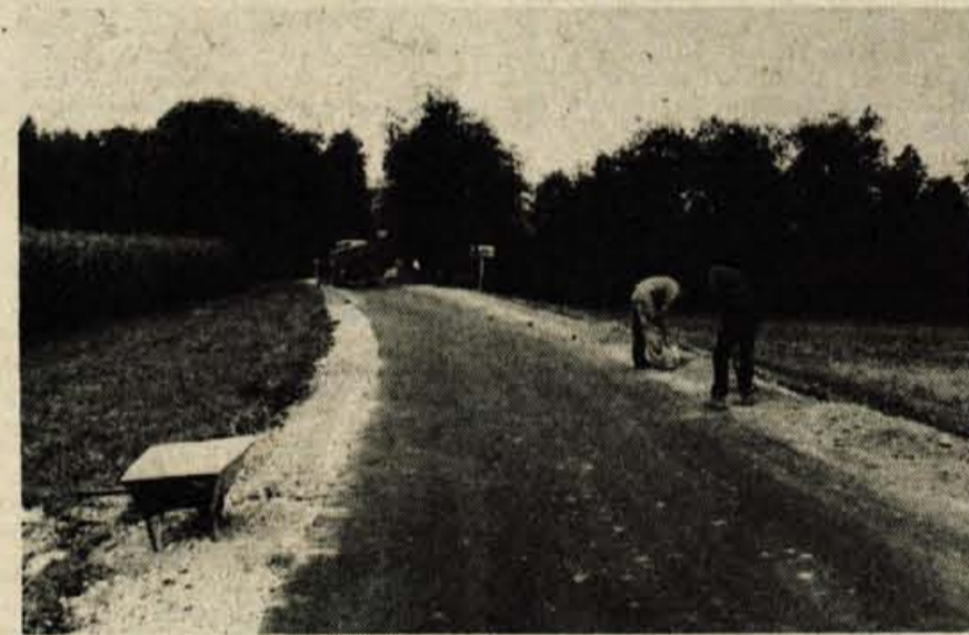
Slabo vzdrževana makadamska, vendar zelo prometna cesta med Puštalom in Soro, ki je vrsto let predstavljala velik kamen spotike v škofjeloški občini, je dobila asfaltno prevleko. Nekaj denarjev so prispevali krajanji KS Skofja Loka v obliki samopriskevka, drugo pa občinska komunalna skupnost. Asfalt je položilo Cestno podjetje iz Kranja. (lb) - Foto: J. Zaplotnik
