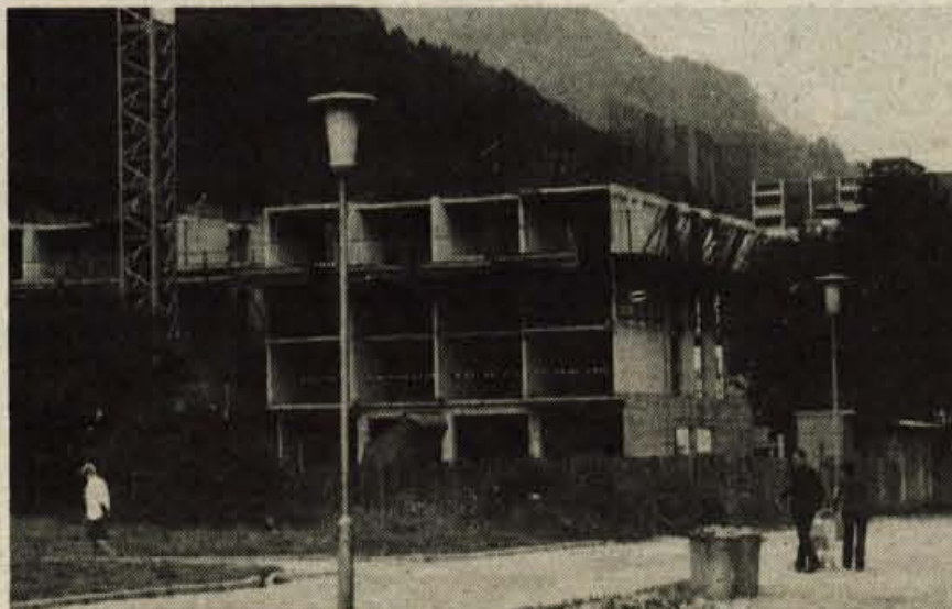
Jesenice - Na jeseniškem Plavžu delavci Gradbinca grade nove stolpnice. Nekaj je že vseljenih, pri nekaterih pa je gradnja zastala zaradi pomanjkanja cementa. Kmalu bodo dokončali tudi stolpnico S-2, v kateri bo 91 stanovanj. - Foto: B. B.
