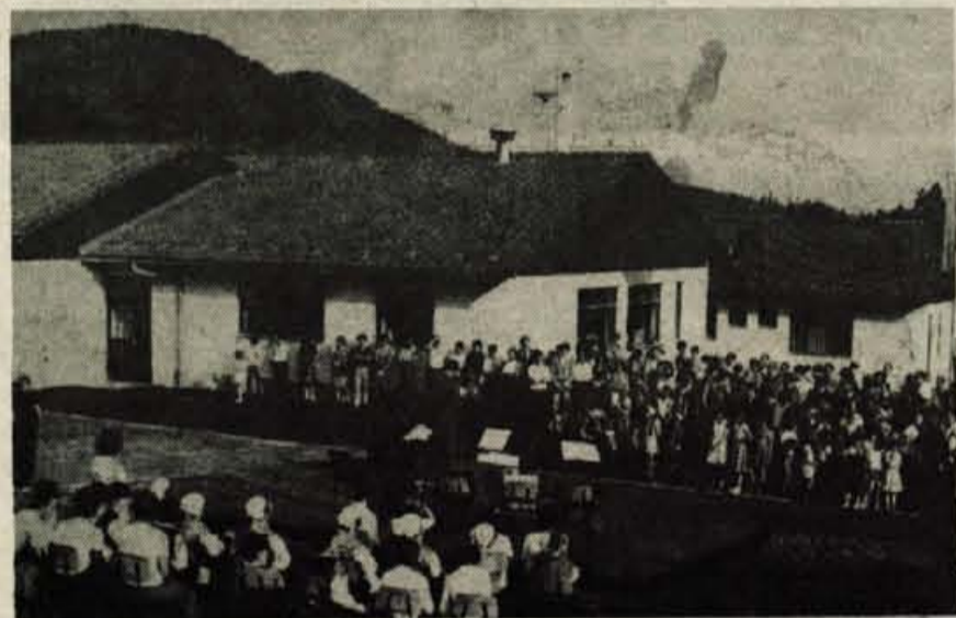
PREDDVOR – Ob šoli v Preddvoru so v soboto popoldne odprli novo vzgojno varstveno ustanovo, ki je prva velika naložba – zgrajena s pomočjo tretjega samoprispevka občanov in delovnih organizacij kranjske občine. Občani krajevnih skupnosti Preddvor, Bela, Visoko in Kokra so z njo pridobili 4 oddelke za varstvo predšolskih otrok, oddelek za podaljšano bivanje učencev ter oddelek za malo šolo. Doslej v Preddvoru niso imeli prostorskih možnosti za družbeno varstvo predšolskih in šolskih otrok. Vrtec v Preddvoru je veljal 7 milijonov 160 tisoč dinarjev. Površina 6 prostorov za igro in učenje ter vseh pomožnih prostorov, med katerimi je tudi zaklonska, je 791 kvadratnih metrov. Sobotne svečanosti so se udeležili tudi številni najvišji predstavniki kranjske občine, predstavniki omenjenih štirih krajevnih skupnosti in drugi gostje. Med njimi so bili tudi predstavniki prijateljskih občin Kotor Varoš in Zemun, ki so se udeležili proslavljanja kranjskega občinskega praznika. M. S. Foto: F. Perdan
