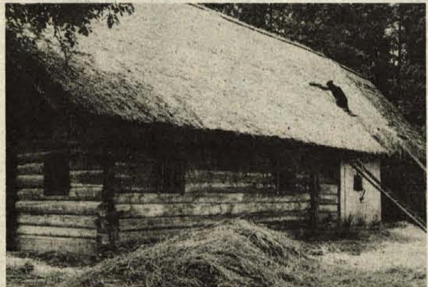
SKOFJA LOKA - Škoparjeva hiša na loškem gradu je dobila novo slamnato streho iz najboljše, ržene slame. Stala bo kot zanimivost, ki jo je najti le redkokje... Foto: F. Perdan
