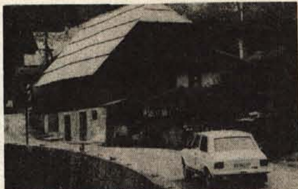
JESEŃICE - V Trebežu pri Javorniku stoji »Skurtnikova« hiša, ki je letos stara 190 let. Njen spodnji del je iz kamna, zgoraj pa je brunarica. Hiša ima vsekakor določeno arhitekturno posebnost. Glede na to, da je zgornji del že precej dotrajan, ga namerava lastnik obnoviti. Foto: B. B.
