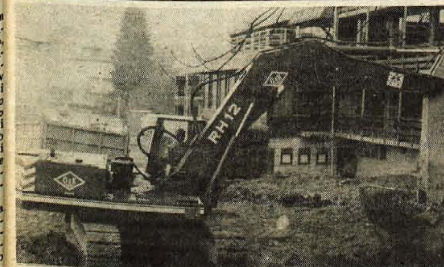
Delavci Gradisa, temeljne organizacije združenega dela Jesenice, delajo pri preureditvi garni hotela Kompas na Bledu. Predvidenja, da bo poslopje lahko sprejelo nove goste do prihodnje turistične poletne sezone na Bledu. - Foto: B. B.
