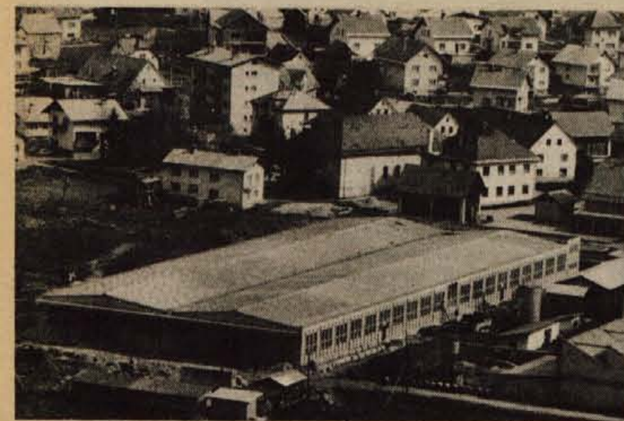
Žiri - Tovarna obutve Alpina iz Žirov se še vedno širi. Prav ob 30-letnici, kolektiv jo bo praznoval v zadnjih dneh aprila, bodo v Žireh odprli novo skladiščno in proizvodno dvorano. Nove prostore s površino 4000 kvadratnih metrov gradi gradbeno podjetje »Savas« z Jesenic. Novi prostori bodo za Alpino izredno pomembni. Alpina je namreč doslej imela svoja skladišča kar na dvajsetih krajih. Obetajo se torej boljše možnosti za delo in tudi razširitev proizvodnje. (-jg) - Foto: F. Perdan
