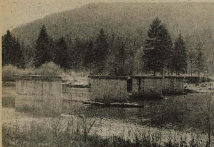
Tile betonski oporniki stojijo v Ribnem že skoraj šest let. Čakajo na most čez Savo Bohinjko. Letos je bilo predvideno, da bo most končno zgrajen, vendar je izgradnjo preprečil potres v Posočju. Gradbenik Pelko z Bleda, ki naj bi ga zgradil, je namreč z gradbeno ekipo delal v Posočju. — J. Ambrožič
