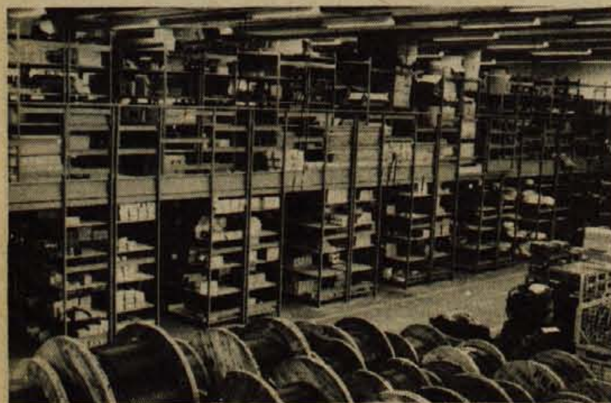
Tudi novo skladišče na Primskovem je pomembna pridobitev kranjskega Elektrotehniškega podjetja. V starem posloju za takšno skladišče ni bilo prostora.
