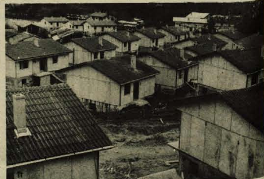
V vasi Sedlo pred Breginjem je škofjeloška Jelovica zgradila 29 montažnih objektov.
