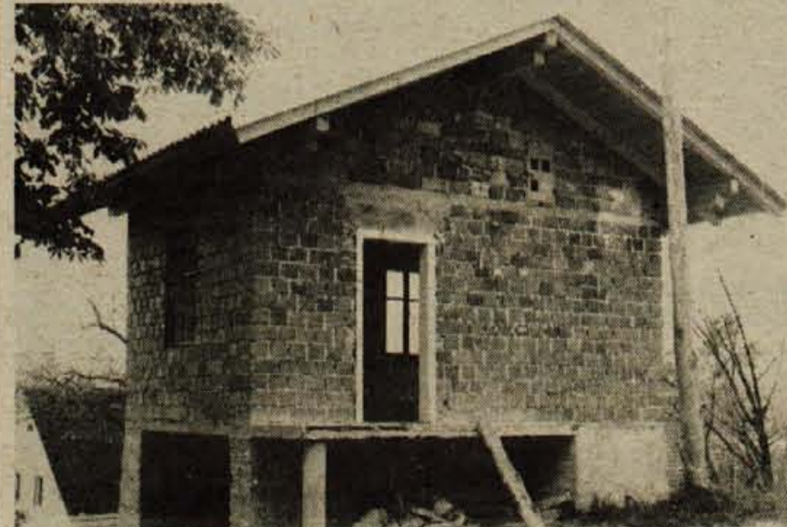
Tupaličah, kjer je še precej kmetij, zberejo dnevno okrog 400 litrov mleka. Zato so se vaščani odločili zgraditi sredi vasi zbiralnico mleka. Prispevali so denar in se lotili gradnje s prostovoljnimi delom. Zato upajo, da jim bosta pri dokončanju zbiralnice in notranjem urejanju pomagala Kmetijska zadruga in mlekarina. (jk) - Foto: F. Perdan
