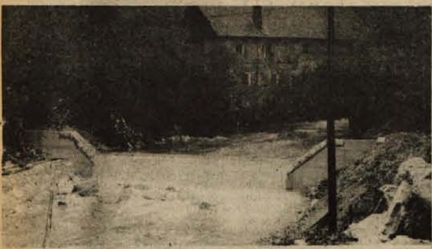
JESENICE — Turistično društvo Jesenice gradi novo TRIM stezo od bolnice, preko Žerjavca in nazaj do izhodiščne točke po strugi hudournika Jesenice. Čez vodno pregrado, ki so jo pred kratkim zgradili delavci Hudournika, bo tekla ena izmed brvi TRIM steze. — Foto: B. B.
