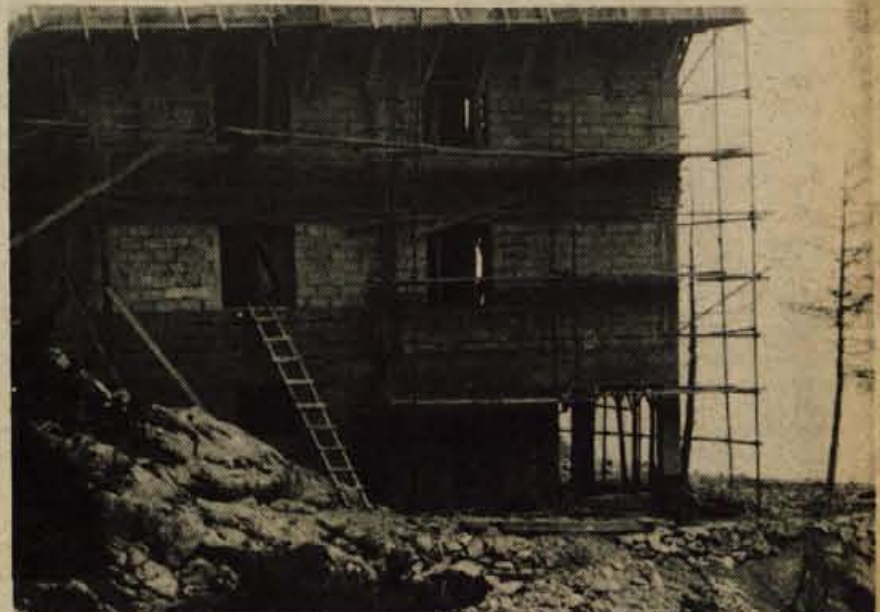
GRADNJA POSTOJANKE NA LEDINAH — Kranjski planinski dom na Ledinah, ki gradi Planinsko društvo Kranj, je zgrajen do druge plošče. Delavci Obrtnega podjetja iz Cerkele ga bodo do zime zaščitili in zaprli, tako da zima objekta ne bo poškodovala. Ledinam pripisujejo velik pomen, saj bo postojanka velikega pomena za planinstvo, alpinizem in smučanje na tem področju, hkrati pa bo omogočala večji obisk Slovencev tega obsejnega področja. Doslej namreč prevladujejo na mejnih vrhovih nemškogovoreči planinci. Že sama gradnja je obisk naših planincev na tem področju povečala. Pred kratkim so gradbišče obiskali tudi najvišji predstavniki kranjske občine, UJV, JLA in predstavniki republiških organov. (jk) — Foto: F. Ekar
