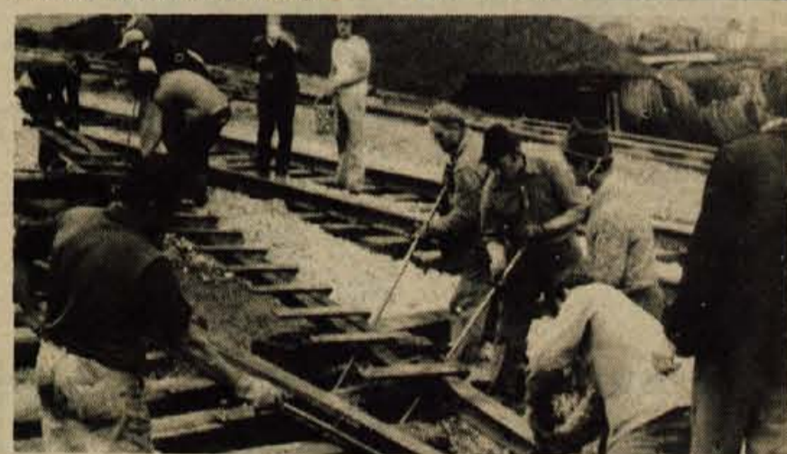
K novemu skladišču Trgovskega podjetja Universal Jesenice grade na Plavškem travniku dva nova železniška tira, kjer bodo na enem prodajno blago razkladali in nakladali, drugi pa bo služil za premik vagonov. Nova tira grade delavci ŽG TOZD Nizke gradnje Ljubljana. - B. B.
