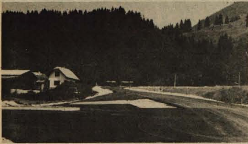
Na obvoznici v Podkorenu je Cestno podjetje iz Kranja položilo asfaltno prevleko in sicer v smeri proti Ratečam in Korenskemu sedlu. Obenem so uredili tudi vse stranske priključke na novo cesto. Delavci SGP Sava Jesenice pa so začeli graditi most čez Savo, ki naj bi bil gotov že to jesen, če ne bo preveč nagajalo vreme. - Foto: A. K.
