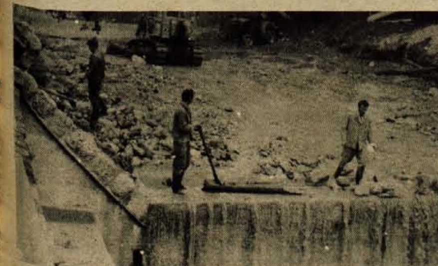
Delavci podjetja Hudournik te dni urejajo dve pregradi na hudourniku Jesenica ter obrežne zidove pri domu starostnikov na Plavžu na Jesenicah. Regulacija hudournika je bila nujna, da ne bi narasla voda začela najedati bregove tik ob novozgrajenem domu dr. Franca Bergla. Dela naj bi bila opravljena še ta mesec. Sredstva za regulacijo je prispevala Gorenjska vodna skupnost, ki ima v letošnjem programu predvidenih 2,9 milijona din za redno vzdrževanje obrežij in pregrad na hudournikih v jeseniški občini. - Foto: B. Blenkus
