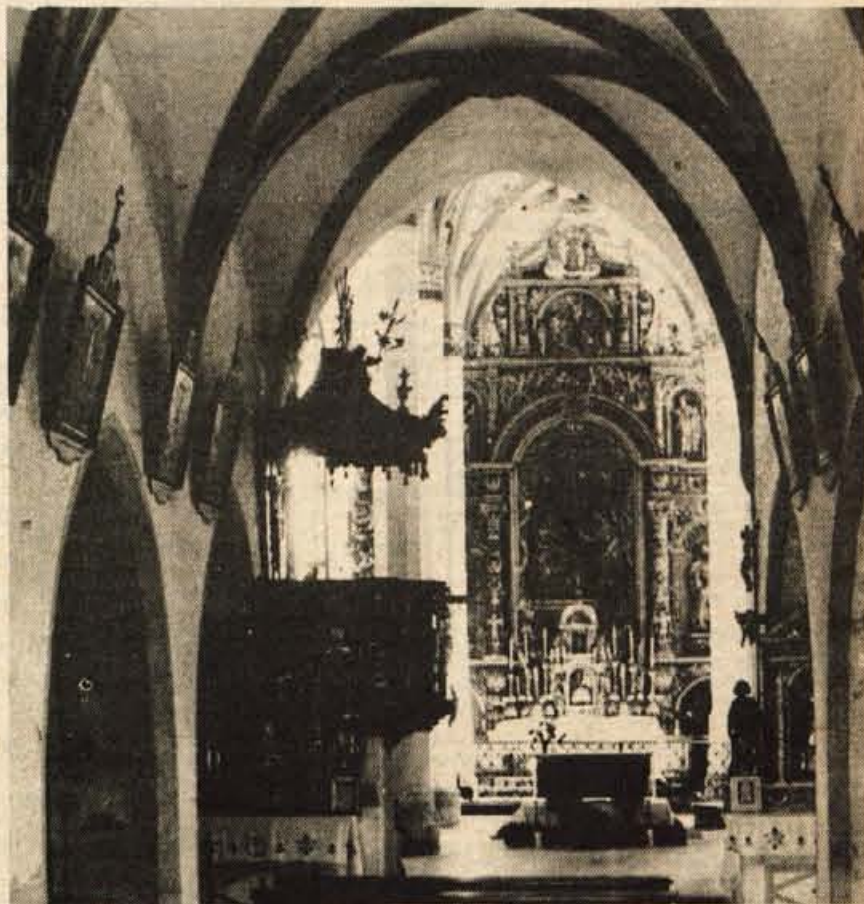
Notranjščina crngrobske božjepotne cerkve - vidno je gotsko stebričje u glavni ladji in značilno rebričje nad presbiterijem.
