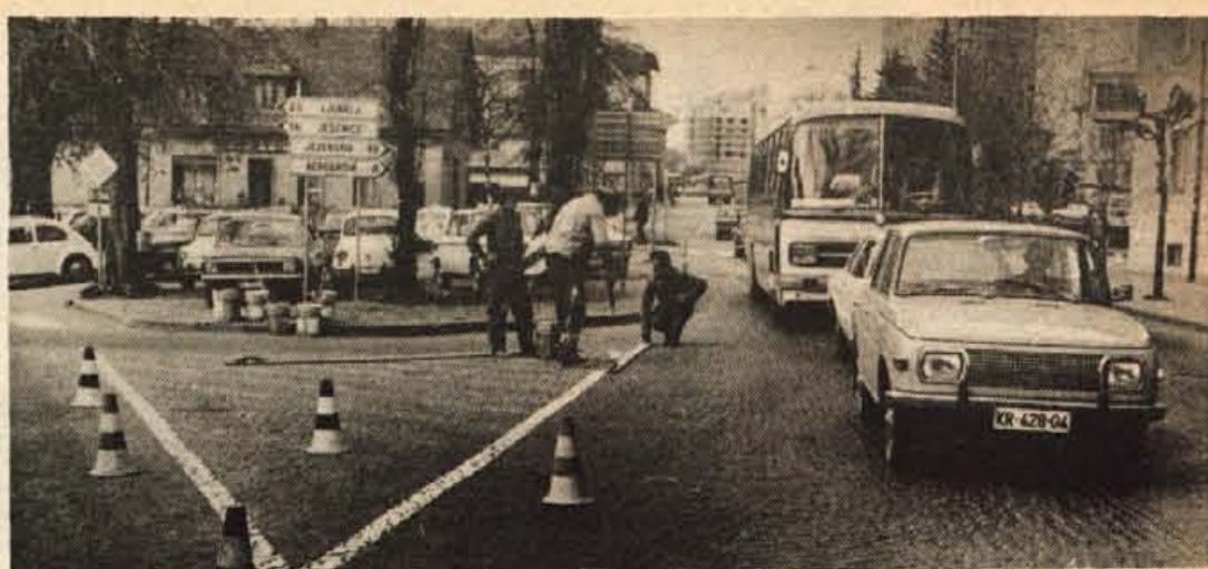
Po naročilu republiške skupnosti za ceste poskrbi Cestno podjetje iz Kranja vsako leto za tako imenovano talno cestnoprometno signalizacijo. V poštavi prihajajo ceste, širše od petih metrov. Na fotografiji urejanje signalizacije na križišču pri Bekselnu v Kranju. (jk) Foto: F. Perdan
