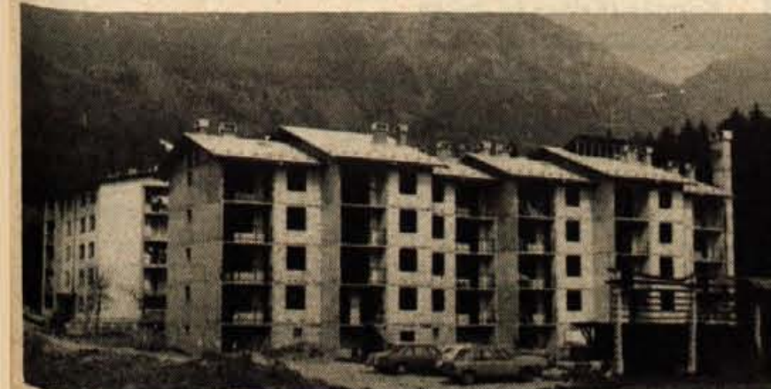
NA GOLNIKU GRADIJO — Delavci Splošnega gradbenega podjetja Projekt iz Kranja, TOZD Trzin, so začeli sredi lanskega leta graditi na Golniku nov stanovanjski blok, ki bo predvidoma vseljiv julija letos. V njem bo 44 enosobnih, dvosobnih in trosobnih stanovanj in garsonjer za delavce Bolniške bolnišnice. (jk) — Foto: F. Perdan
