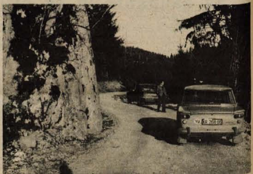
Spomladi bodo dokončali še slab kilometer nove 3,7 kilometra dolge ceste iz Jereke v Podjelje
