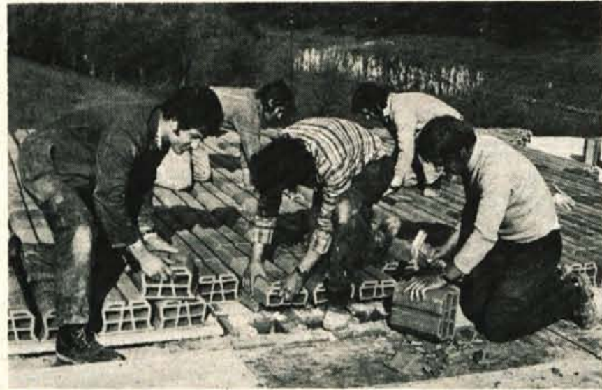
Pri odpravljanju posledic potresa in gradnji novih hiš so se delavci gorenjskih gradbenih podjetij dobro izkazali.
