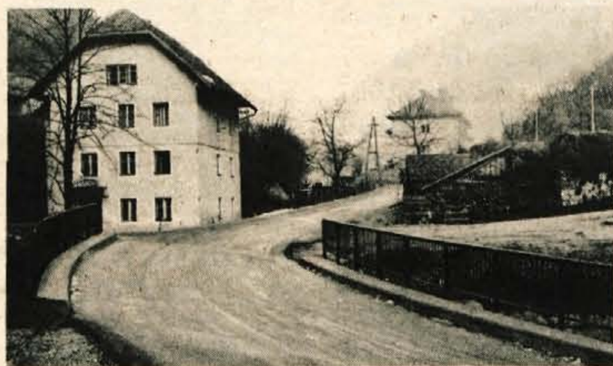
NA RAVNAH V TRŽIČU ASFALTIRANA CESTA — V počastitev 29. novembra so na Ravnah v Trziču odprli zadnji odsek asfaltirane ceste skozi najsevernejši del Trziča. Za vgraditev asfalta je večino sredstev prispevala občinska skupščina Trzič in s tem rešila več let trajajoči problem. Cestni odsek je odprl predsednik izvršnega sveta občinske skupščine Trzič inž. Vili Logar. Na Ravnah bo tako lahko začel voziti tudi lokalni avtobus. Obenem je bila pri bližnjem spomeniku na Čegelšah tudi proslava. (jk) — Foto: F. Perdan
