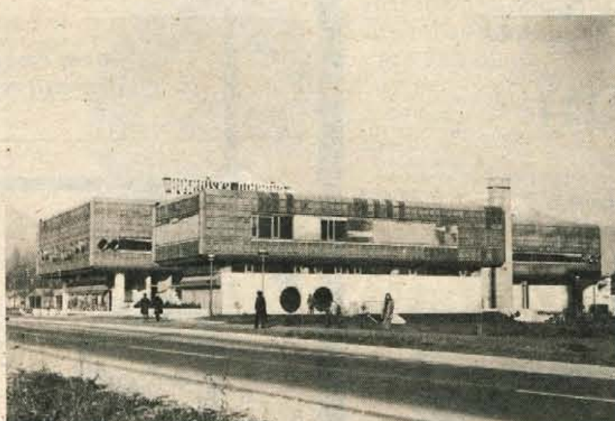
V krajevni skupnosti je več podjetij in ustanov. Urbanizirano okolje lepo dopolnjuje nova zgradba podjetja Gorenjska oblacija.
