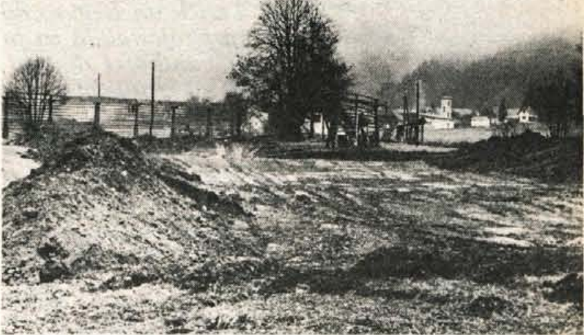
V PODKORENU GRADIJO — Splošno gradbeno podjetje Sava z Jesenic je 10. novembra začelo graditi nova cestna odseka od Kranjske gore do Rateč in odsek od Podkorena proti Korenskemu sedlu. Odseka bosta naselje Podkoren obšla in omogočila boljši dostop do mejnih prehodov v Ratečah in na Korenskem sedlu. Sedanja cesta skozi Podkoren je zaradi gostega prometa resnično ozko grlo, ki povzroča številne zastoje in je nevarnost tako za voznike kot za domačine. (jk) — Foto: F. Perdan
