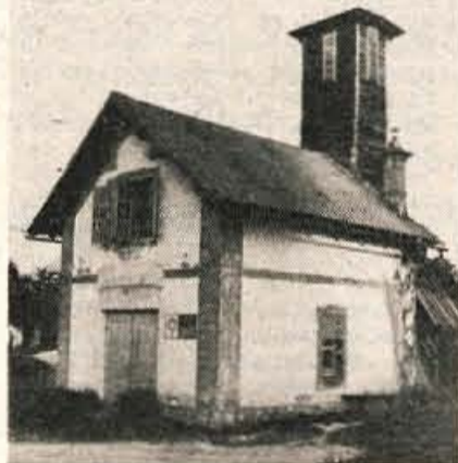
Stari gasilski dom v Zasipu nad Bledom je že porušen
