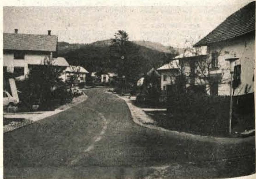
Letos je bil asfalt položen na več kot dva kilometra dolgih odsekih v Žireh.
