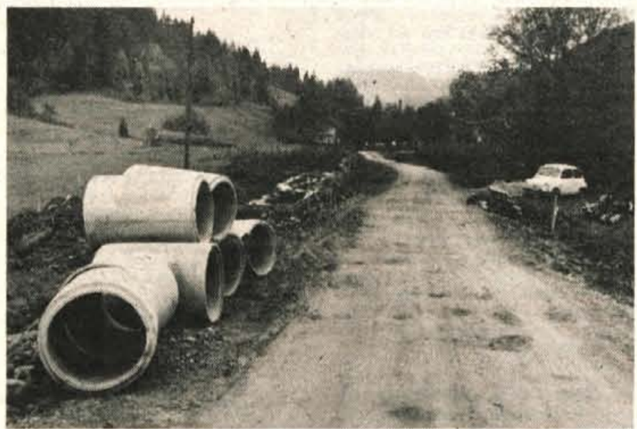
Tudi cesta v Račevu bo dobila asfaltno prevleko.
