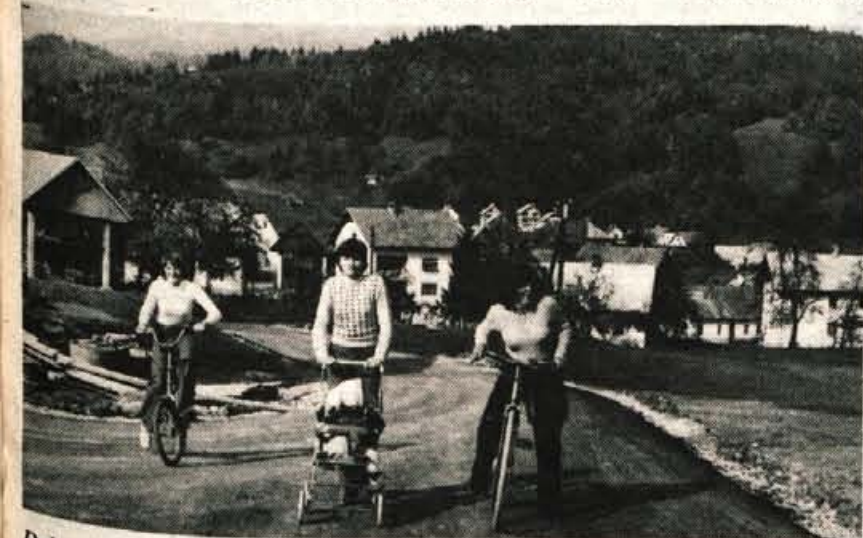
Delavci cestnega podjetja iz Kranja so te dni tudi na ceste v Gorenji vasi v Poljanski dolini položili asfalt. Prvi asfaltirani odsek je dolg nekaj več kot 700 metrov, drugi pa nekaj več kot 500 metrov. Vsa dela so veljala več kot 650.000 din, poleg tega pa so domačini žrtvovali še prek 1000 prostovoljnih delovnih ur. Za asfaltiranje so precej denarja prispevali prebivalci, ki so vezani na ta dva cestna odseka (od 1000 do 5000 din), poleg tega pa so sredstva pritekala še iz sklada, kjer se zbirajo prispevki za mestno zemljišče, nekaj odstotkov je krajevna skupnost namenila iz sredstev za redno vzdrževanje ter iz anuitet letos na novo asfaltirane hotaveljske ceste, ki je na področju gorenjevaške krajevne skupnosti. (jg) — Foto: F. Perdan
