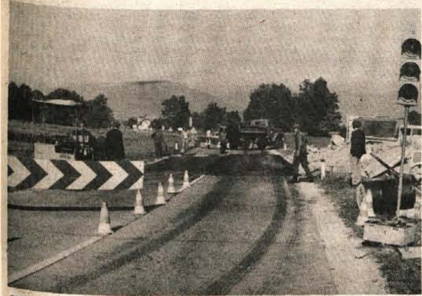
Cestno podjetje iz Kranja se je ta teden lotilo zamenjave dotrajanih in poškodovanih betonskih plošč na glavni gorenjski cesti z asfaltnimi vložki. Če bi dotrajane plošče zamenjevali z novimi, bi bil promet zaprt ali vsaj otežen najmanj tri tedne. Z vgrajevanjem asfalta je soglašala tudi Republiška skupnost za ceste (jk) — Foto: F. Perdan
