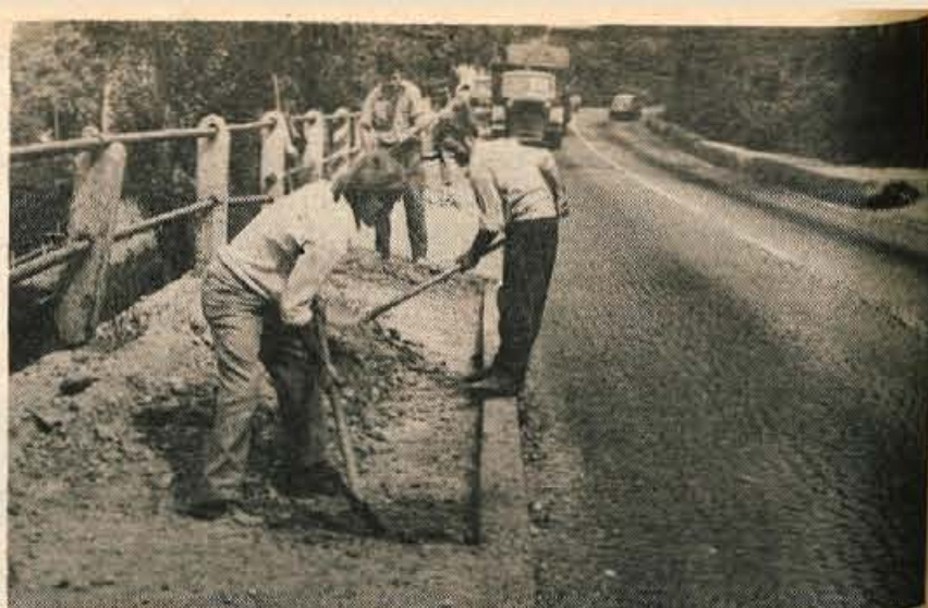
Delavci Cestnega podjetja iz Kranja so začeli urejevati pločnik na Jelenovem klancu v Kranju. V kratkem bodo na pločniku položili asfalt in s tem pomagali predvsem pešcem, ki jih na klancu ne manjka. Urejevanje Jelenovega klanca financira kranjska občinska skupščina (jk) - Foto: F. Perdan
