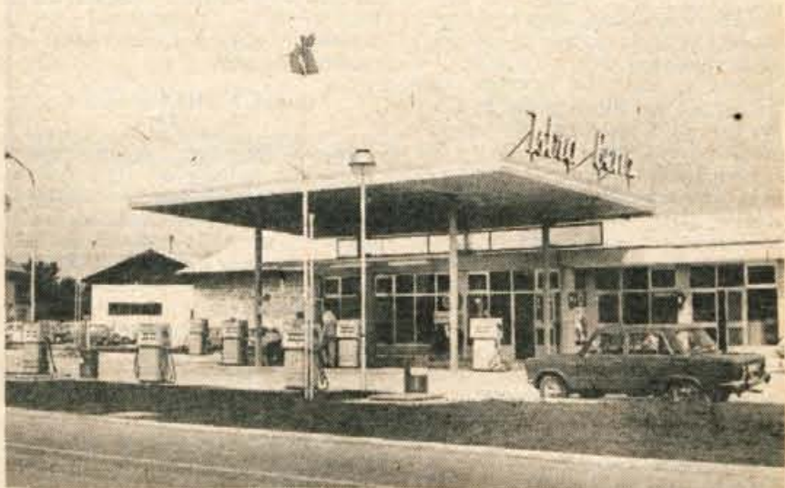
NOVA BENCINSKA ČRPALKA NA PRIMSKOVEM — Pred dnevi je podjetje Istra-Benz iz Koprna odprlo na Primskovem ob cesti proti Brniku novo bencinsko črpalko s sedmimi točilnimi agregati. Razen tega je na novi črpalki mogoče dobiti tudi motorni petrolej in kurilno olje. Značilnost nove črpalke bo bife, ki ga bo prevzelo eno od kranjskih gostinskih podjetij. Črpalka je odprta od šestih zjutraj do osmih zvečer. Istra-Benz ima tako na Gorenjskem že štiri črpalke. Največja je v Medvodah, sledi pa ji kranjska, ki je druga največja, leška in črpalka v Mostah pri Komendi. (jk) — Foto: F. Perdan
