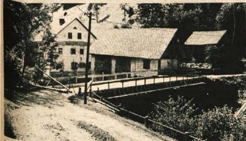
Prebivalci Fužin ter okoličani v krajevni skupnosti Trebija v Poljanski dolini so te dni priča pomembni pridobitvi. V kraju so namreč zgradili prepotreben most prek reke Sore. Dosedanji, ki je bil lesen, zaradi dotrajanosti že nekaj let ni dovoljeval, da bi se prek njega odvijal kakršenkoli težji promet. Ko bo nov most dokončno dograjen, se bo pot med Sovodnjem in Žirni skrajšala za približno tri kilometre. Denar za gradnjo so prispevali skupščina občine Škofja Loka, krajevna skupnost Trebija, domačini pa so pri gradnji žrtvovali več sto prostovoljnih delovnih ur. (jg) — Foto: F. Perdan
