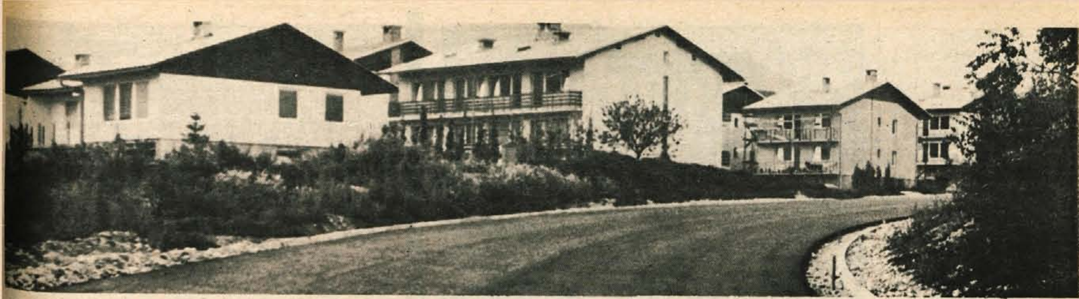
Ozko prometno grlo na cesti v Selško dolino, odsek skozi Staro Loko, bo v kratkem odpravljeno. Delavci SGP Tehnik iz Škofje-Loke in Cestnega podjetja iz Kranja zaključujejo z deli na 800 metrov dolgi obvoznici od škofjeloške Name do konca naselja Stara Loka. — Foto: F. Perdan
