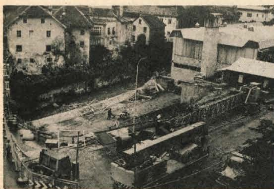
GRADBIŠČE NOVE AVTOBUSNE POSTAJE V TRŽIČU — Tržiška temeljna organizacija združenega dela Projekt iz Kranja je začela graditi v Trziču novo avtobusno postajo. Investitorja novega objekta, v katerem bo razen postajališča in prometne pisarne tudi gostinski obrat, sta SAP Ljubljana in gostinsko podjetje Zelenica. Avtobusna postaja bo predvidoma izročena namenu prihodnje leto. (jk) — Foto: F. Perdan
