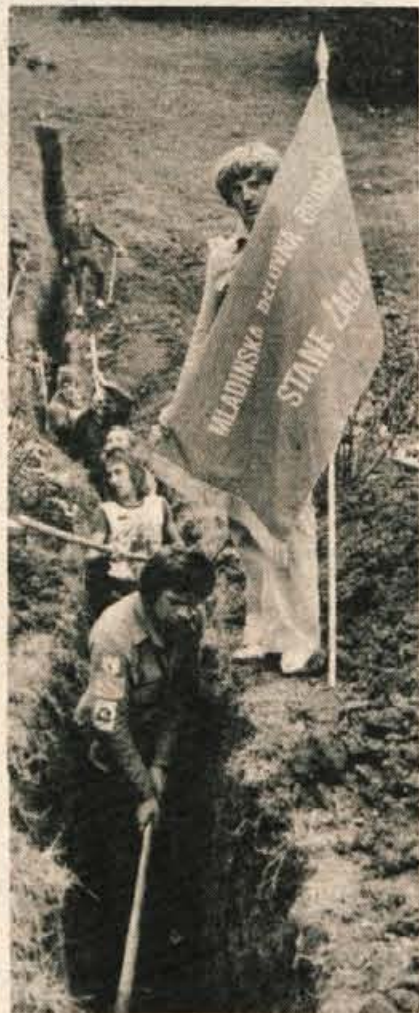
Do nedelje bodo brigadirji izkopali nekaj sto metrov dolg jarek za vodovod
