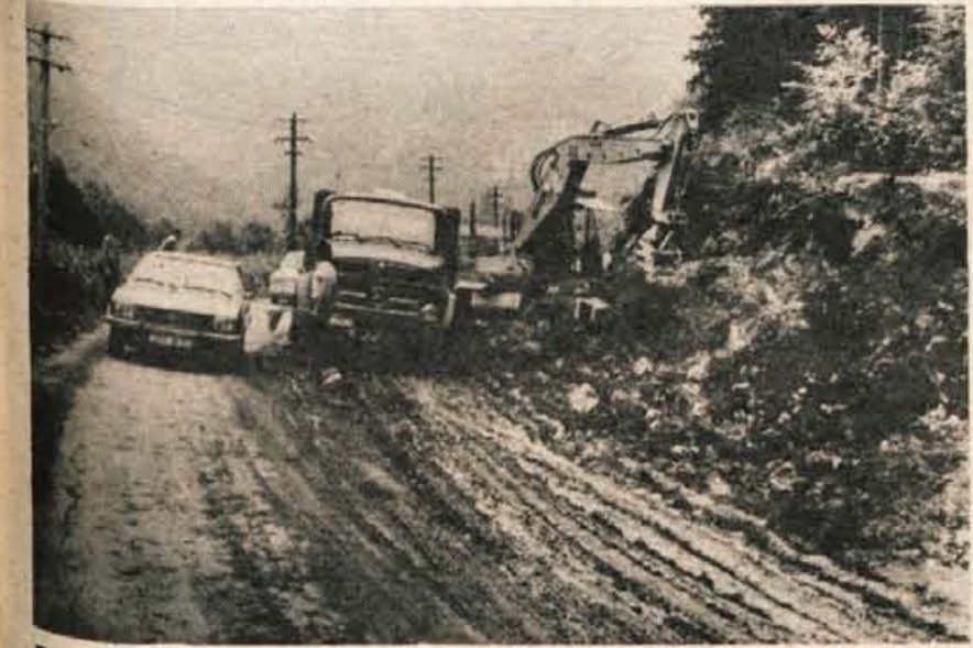
Pred približno mesecem dni je Cestno podjetje iz Kranja dokončno uredilo in asfaltiralo odsek bohinjske ceste v Soteski. Pred dnevi pa so začeli nadaljevati z rekonstrukcijo v smeri proti Bledu. Vrednost del bo znašala okrog 4 milijone novih dinarjev vključno s stroški za pred mesecem dni položeni asfalt. Računajo, da bodo dela na novem odseku končali še letos. - A. Ž. - Foto: F. Perdan
